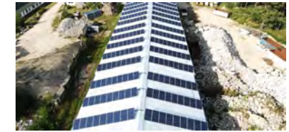
PVA Lohmen II 96 kWp Prognose: 935,57 kWh/kWp Ø der letzten 4 Jahre: 1015,69 kWh/kWp
