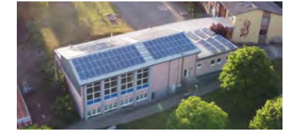
PVA Ballweiler 35 kWp Prognose: 916,2 kWh/kWp Ø der letzten 4 Jahre: 950,5 kWh/kWp
