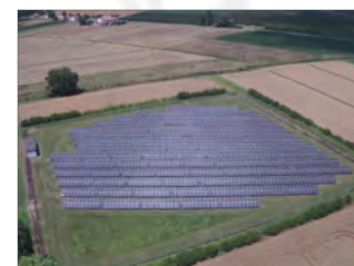
Italien Freifläche in Betrieb 500 kWp
