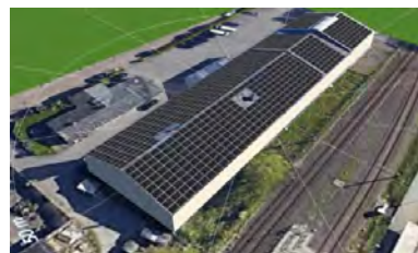
Niedersachsen voraussichtlich 296 kWp
