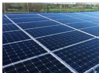
Deutschland Abbau Anlage 577 kWp
