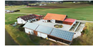
PVA Neukirchen 24 kWp Prognose: 986,78 kWh/kWp Ø der letzten 4 Jahre: 1092,63 kWh/kWp
