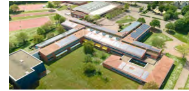
PVA Alzey 213 kWp Prognose: 954,00 kWh/kWp Ø der letzten 4 Jahre: 988,00 kWh/kWp
