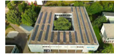
PVA Rutesheim 29 kWp Prognose: 990,7 kWh/kWp Ø der letzten 4 Jahre: 1225,60 kWh/kWp
