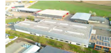
PVA Bad Lippspringe 162 kWp Prognose: 966,96 kWh/kWp Ø der letzten 4 Jahre: 1092,63 kWh/kWp
