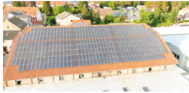
PVA Schöningen 57 kWp Prognose: 991,78 kWh/kWp Ø der letzten 4 Jahre: 1109,71 kWh/kWp
