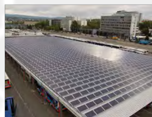
Deutschland Abbau Anlage 405 kWp
