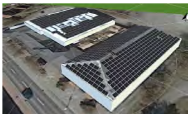
Brandenburg voraussichtlich 385 kWp
